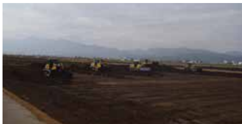
北海道開発局 旭川開発建設部 富良野盆地地区 報徳四工区区画整理工事
