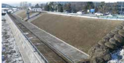
北海道開発局 旭川開発建設部 石狩川改修工事の内 永隆右岸堤防強化工事
