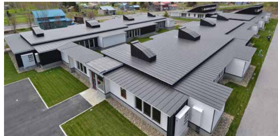
一の橋集住化住宅
