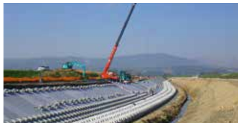
北海道開発局 旭川開発建設部 石狩川改修工事の内 辺別川旭橋上流低水路保護工事
