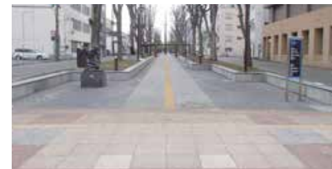
旭川市土木部 7条公園通線改良その3工事
