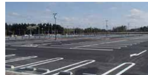
酒々井プレミアム・アウトレット外構工事(千葉県)
