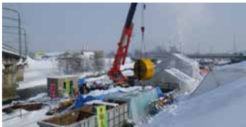
北海道開発局 旭川開発建設部 石狩川改修工事の内 永隆左岸築堤堤防強化工事 推進工法:掘削用推進機
