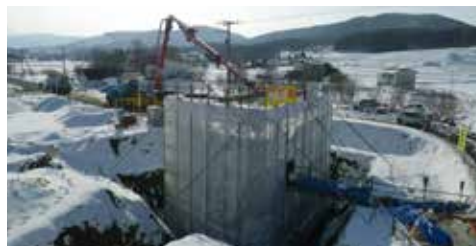
北海道十勝総合振興局 旭川建設管理部 (301) 瑞穂旭川停車場線防災B (地方道) 工事(補正・明許) 外
